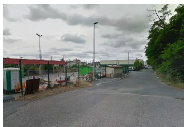
L'emprise SNCF depuis la rue Jean Monnet
